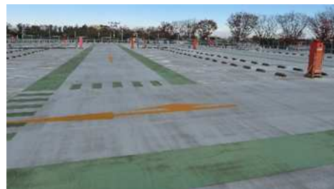
総合運動場立体駐車場
