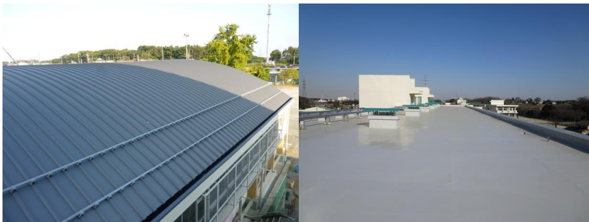
左図：屋内運動場屋根改修工事（北秋津小学校）、右図：屋上防水改修工事（柳瀬小学校）
