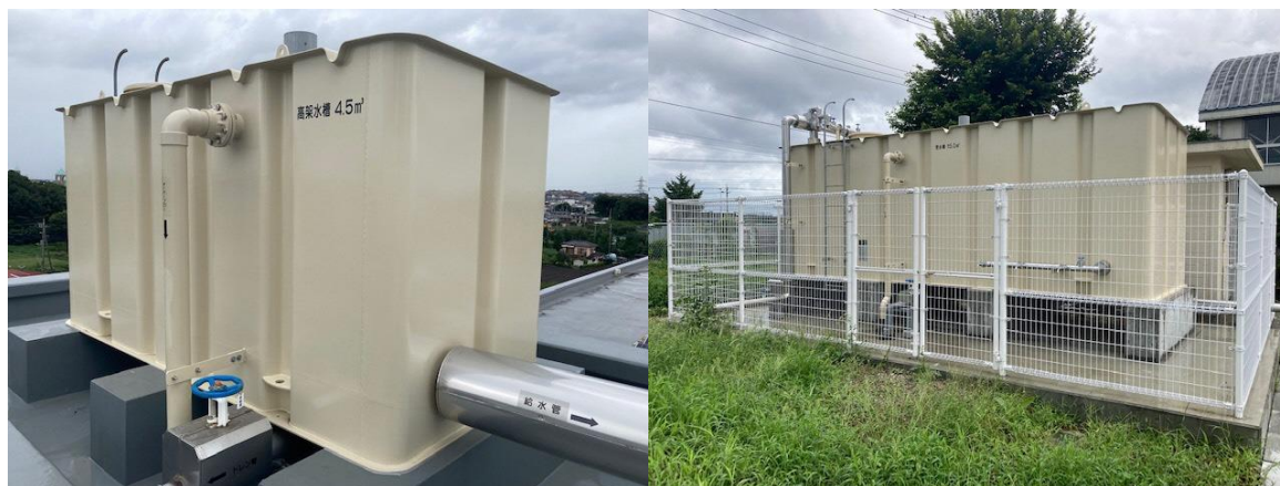
受水槽改修工事（北野中学校）
