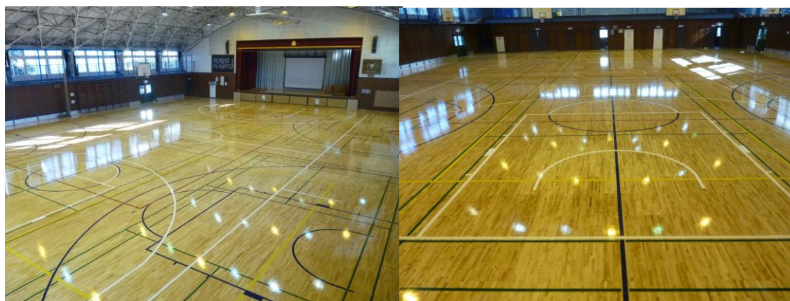
屋内運動場床改修工事 (美原中学校)
