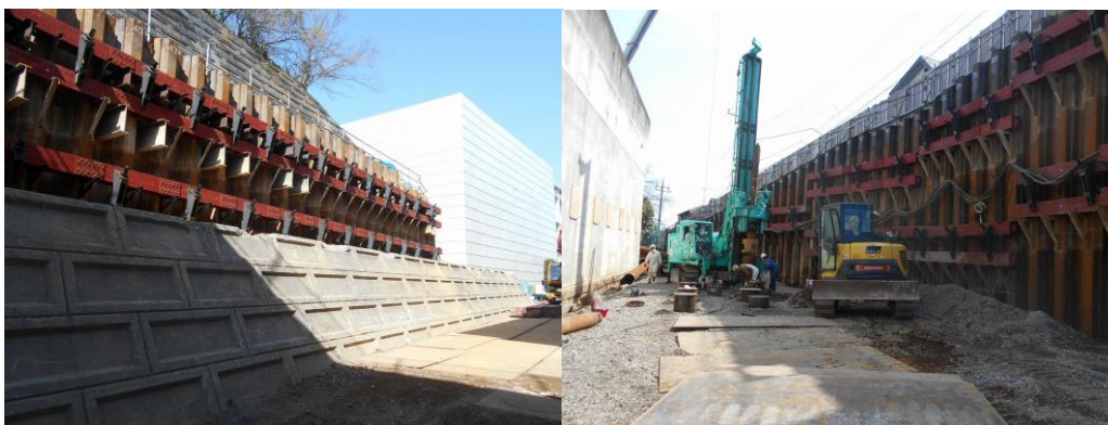
既存擁壁改修工事（山口中学校）
