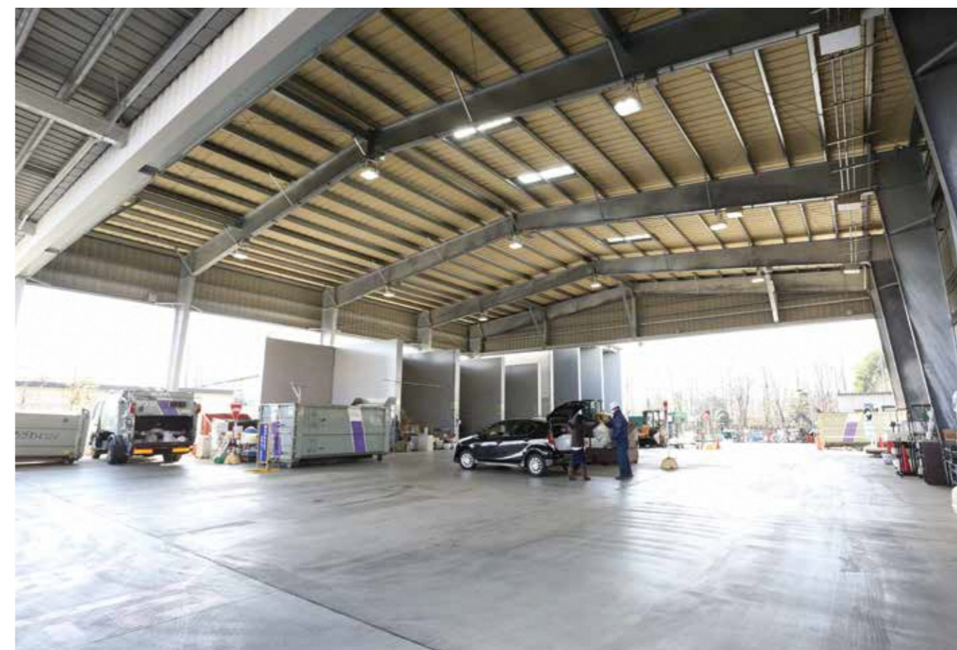
受入ステージ棟(内部)
