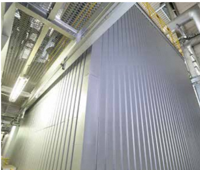
集じん装置 排ガス中の灰や有害物質を取り除くための設備です。390本のろ布と呼ばれるフィルタが装置内に設置されています。入口で薬剤を吹き込むことでダイオキシン類や塩化水素、硫酸酸化物を低減できます。
