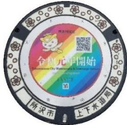
令和元年度、太陽光パネルで作った電気で光らせるイルミネーションマンホール蓋を設置。令和2年度以降、KADOKAWAの作品を題材としたイルミネーション蓋等を30箇所を設置。
