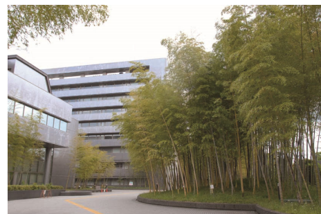
市庁舎外周部の緑化
