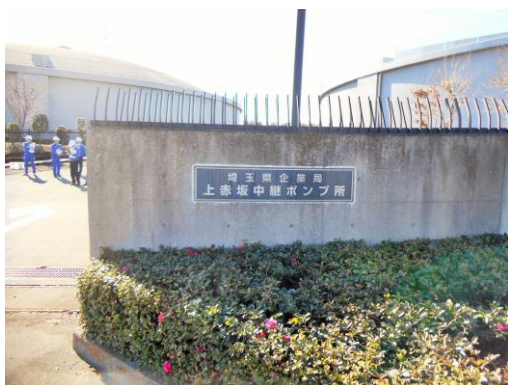
上赤坂中継ポンプ所
