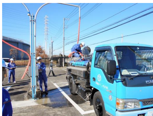
給水車両への補水
