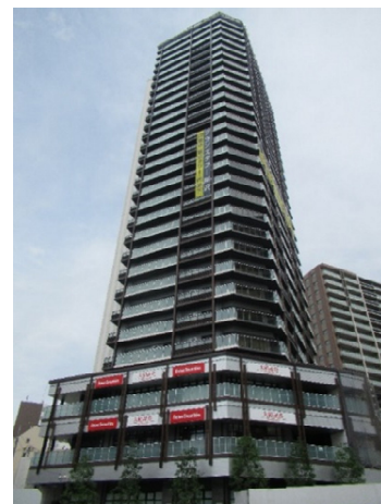
所沢東町地区第一種市街地再開発事業 施設建築物(令和4年1月竣工)
