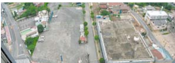
▲文化・コミュニティ活動の拠点施設の建設前（左）と完成後（上）
