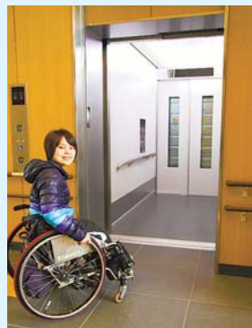
▲車いすでも使いやすいウォークスルー式エレベーター
